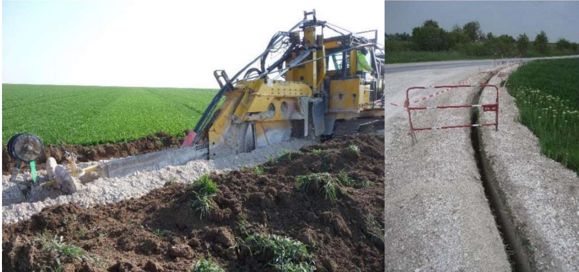
Figure 6 : Exemple de tranchée réalisée (Source : TotalEnergies).
